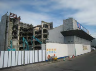
▲解体が進む旧丸光デパート (H22/9/11撮影)
