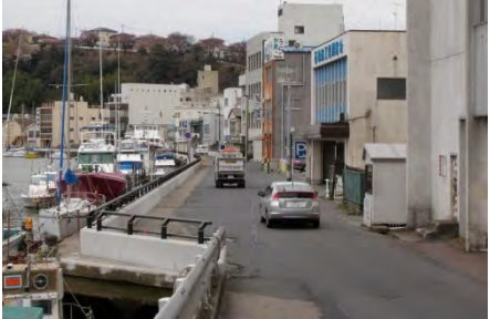
▲河岸沿いに国土交通省で整備した高潮対策(コンクリート壁)
