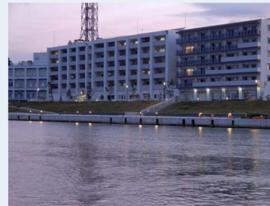
内海橋から見た状況
