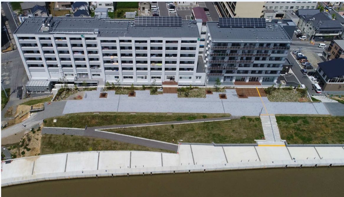
完成後の状況 (上空より全体を見る : 平成30年5月末現在)
