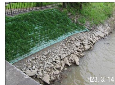
取り付け部法面の崩落
