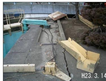
開閉機の破損（旧北上川側）
