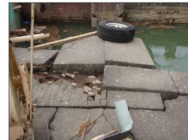
沈下・欠損の拡大
