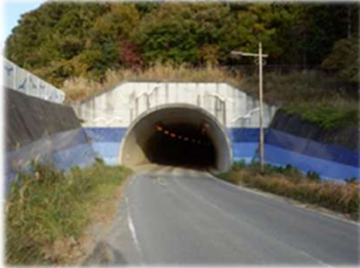
市道梨木畑・祝田藤ヶ崎線 サン・ファントンネル(1996年竣工)
