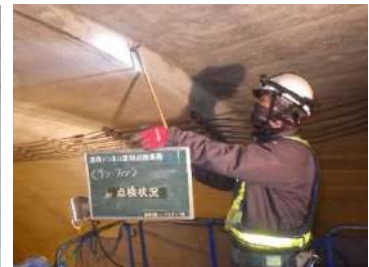
近接目視・打音検査状況
