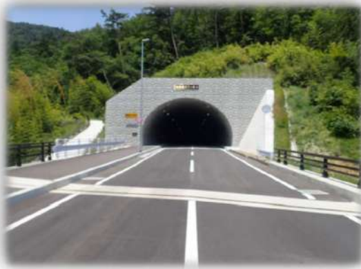
市道黄金浜七ノ坪線 渡波稲井トンネル(2021年竣工)
