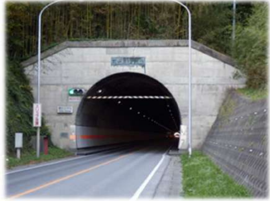
市道中卒塚橋石巻大橋伊原津一丁目線 牧山東トンネル(1973年竣工)
