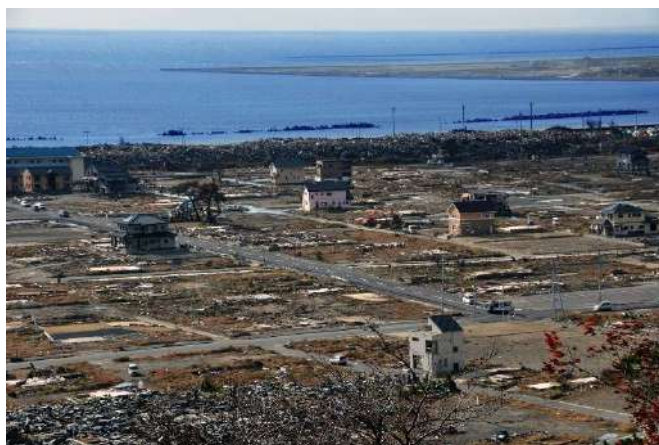
震災 津波後の住宅地の状況
