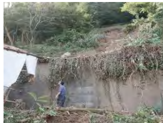
2019年(令和元年)10月 台風19号による土砂崩れ
