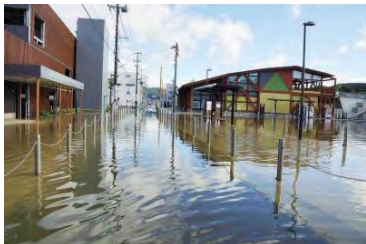
2019年(令和元年)10月 台風19号による浸水被害
