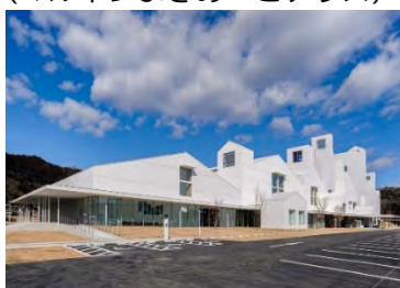
石巻市複合文化施設 (マルホンまきあーとテラス)
