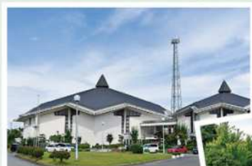
桃生综合中心
