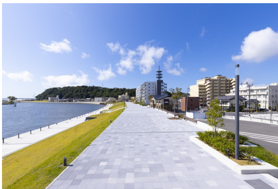
《図4-4 旧北上川河口域の整備状況》 写真：国土交通省 北上川下流河川事務所
