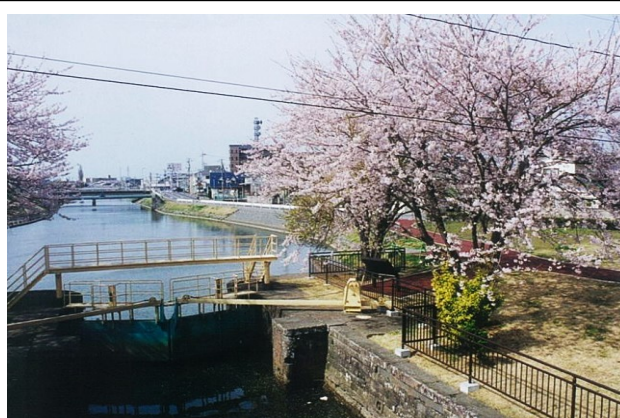
《図4-5 石井閘門（国重要文化財）》
