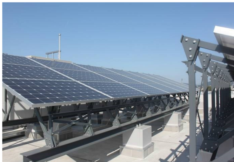
《図 2 - 5 太陽光発電システム（石巻消防署西分署）》
