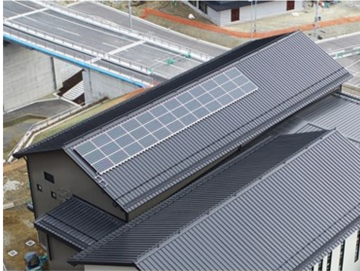
《図 2－5 太陽光発電システム（石巻市雄勝総合支所複合施設庁舎）》
