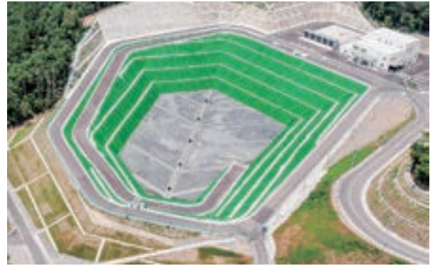
石巻市大衡山一般廃棄物最終処分場
