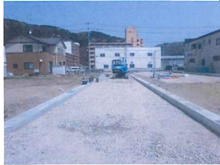
【側溝敷設状況】
