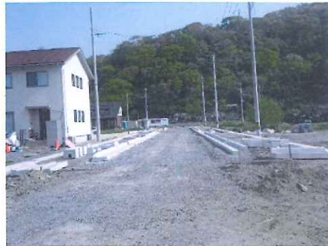
【L型側溝敷設状況】
