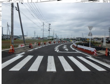
【暫定開通状況】
