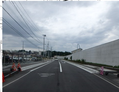
【車道舗装状況】
