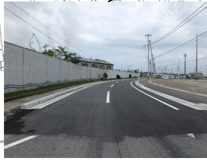
【車道舗装状況】
