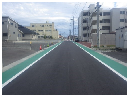
【道路舗装完了】
