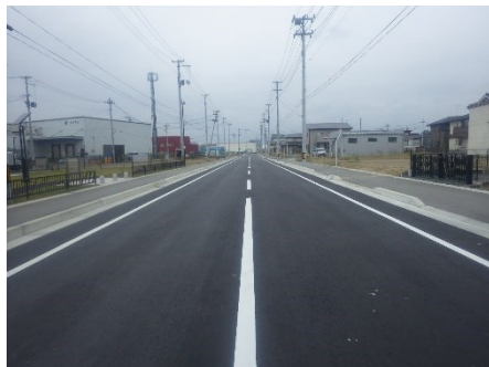
【道路舗装完了】
