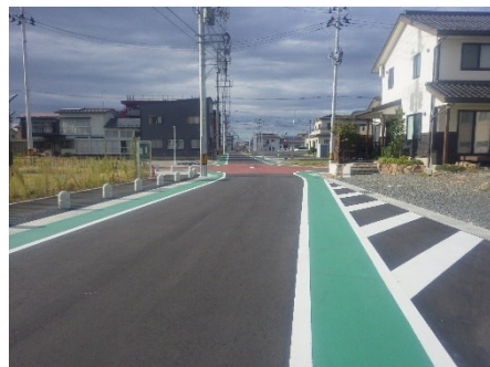
【道路舗装完了】
