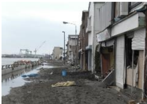
▲旧北上川右岸 門脇地区の被災状況(3月15日撮影)
