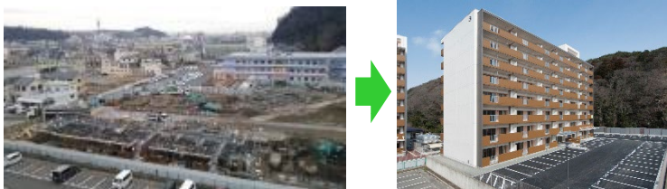
吉野町一丁目地区 工事状況
