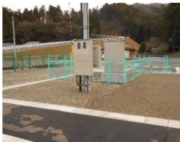
<工事完了後（3号ポンプ）>
