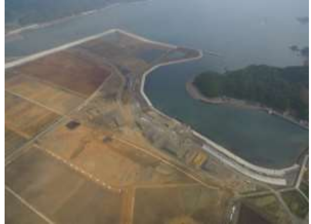
<工事用道路完成後>
