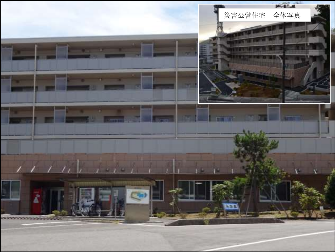
整備後（石巻市老人福祉センター寿楽荘正面）
