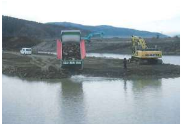
<工事用道路から残土を搬入している写真（平成30年10月）時点（参考）>
