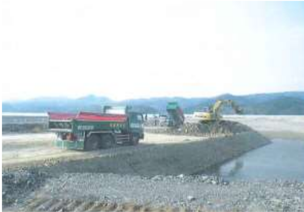
<工事用道路から残土を搬入している写真（平成30年10月）時点（参考）>
