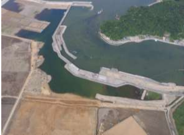
<工事用道路着手前>
