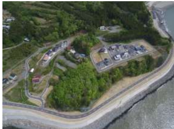
完成した移転団地
