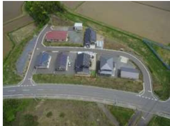
完成した移転団地
