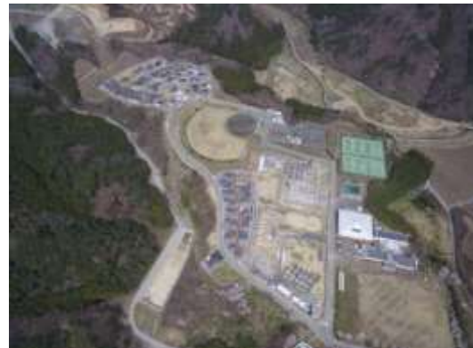
完成した移転団地
