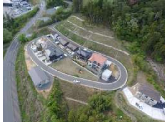
完成した移転団地
