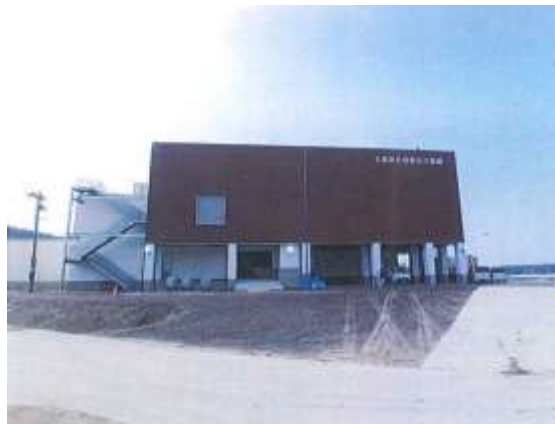
<製氷冷蔵庫・整備後>
