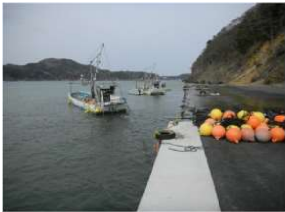
谷川漁港（谷川地区） 用地嵩上げ
