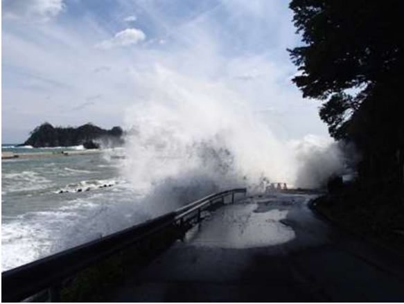
泊漁港 道路護岸
