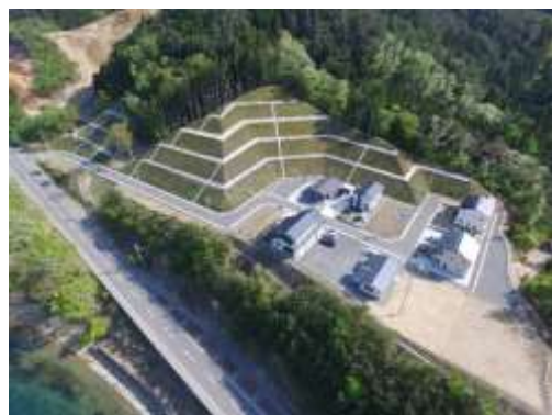
完成した移転団地
