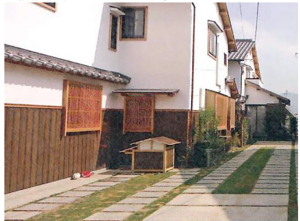
設備機器等をカバーして景観に配慮した例 *1
