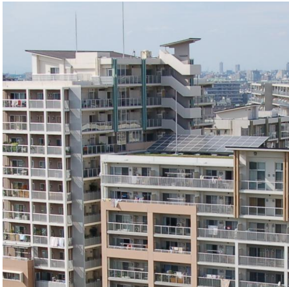
住棟屋根に太陽光パネルを設置した例
