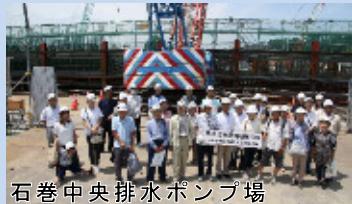
石巻中央排水ポンプ場
