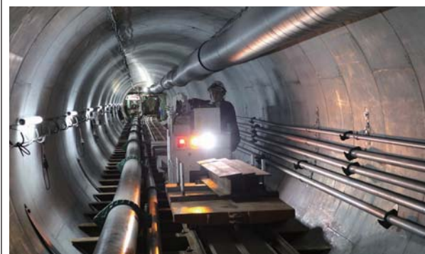
組立後の管渠内部
