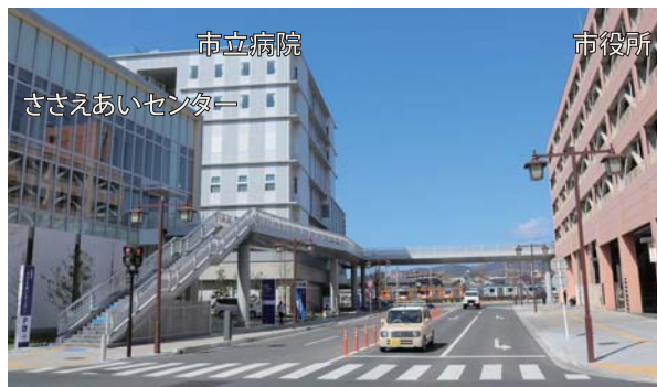
連結された「ささえあいセンター・市立病院・市役所」
