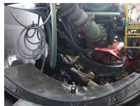
トンネル先端部での管材料組立
