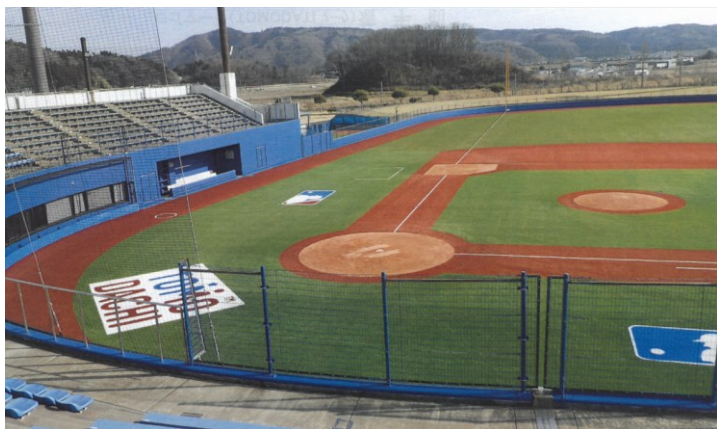
石巻市民球場人工芝改修工事
