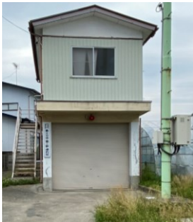
▼消防ポンプ置場
