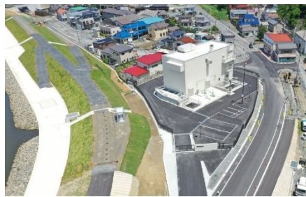
井内第一排水ポンプ場
