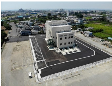
北北上運河右岸第二排水ポンプ場
