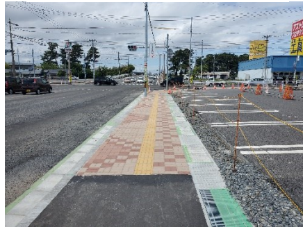
避難路整備（中浦橋釜北橋線）
