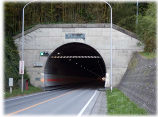
市道中塚橋石巻大橋伊原津一丁目線 牧山東トンネル(1973年竣工)
