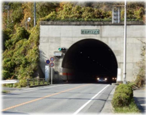
市道中塚橋石巻大橋伊原津一丁目線 牧山西トンネル(1972年竣工)
