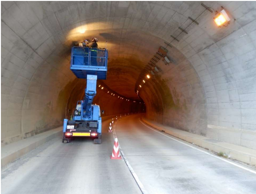
定期点検状況（サン・ファントンネル）
