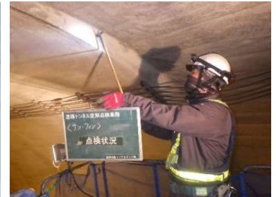
近接目視・打音検査状況
