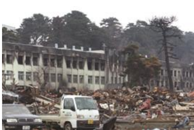
震災遺構として一部又は部分保存が決定した旧門脇小学校校舎
