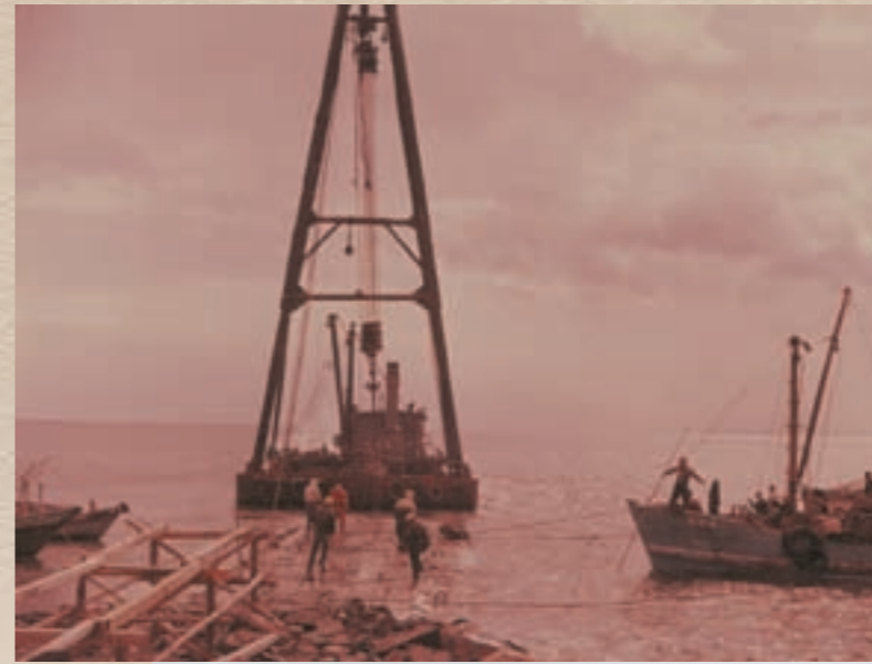
工業港の基礎工事 (昭和37年頃)
