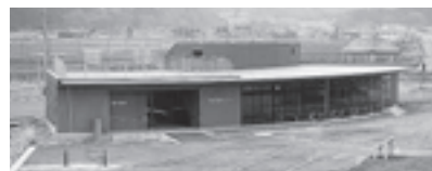
▲北上水辺センター外観
