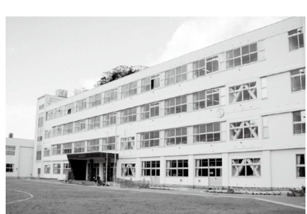
湊小学校(平成19年度耐震補強・大規模改造工事)
