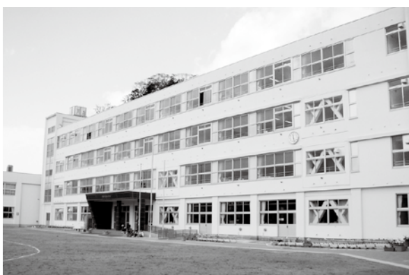
▲ 湊小学校（平成19年度耐震補強・大規模改造工事）
