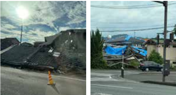
令和8年8月熊本地震で倒壊した住宅（熊本県八代市） 令和8年8月15日撮影
