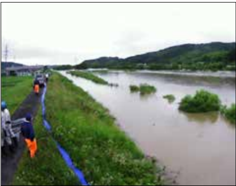
及川橋上流（江合川右岸2.8km付近）
