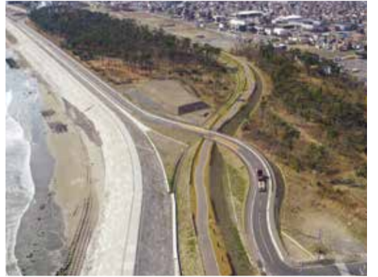
防潮堤・防災緑地2号(渡波)
