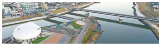
内海橋・河川堤防
