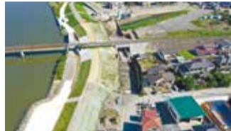
河川堤防(井内)
