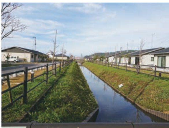
新渡波地区の土地区画整理事業(さくら町)
