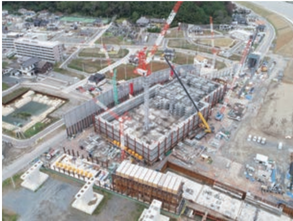
整備中の下水道施設(石巻中央排水ポンプ場)
