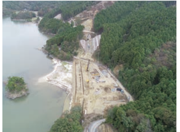
整備中の一般市道(屋敷浜猪落線)
