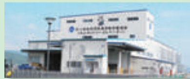
▲北上カントリーエレベーター 供用開始 (平成25年10月)
