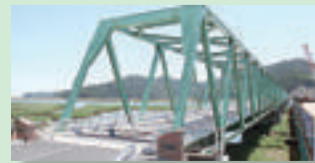
▲新北上大橋復旧 (平成28年6月)
