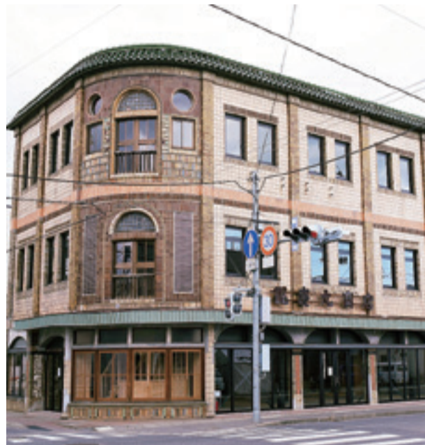
▲修理完成した「旧観慶丸商店」
