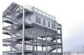
津波避難タワー
