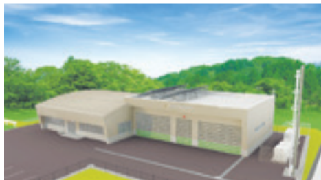
▲建物は、鉄筋コンクリート造1階建となります。
