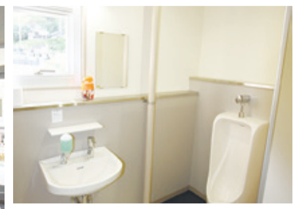
▲トイレは全面改修されました。換気扇も一新しました。
