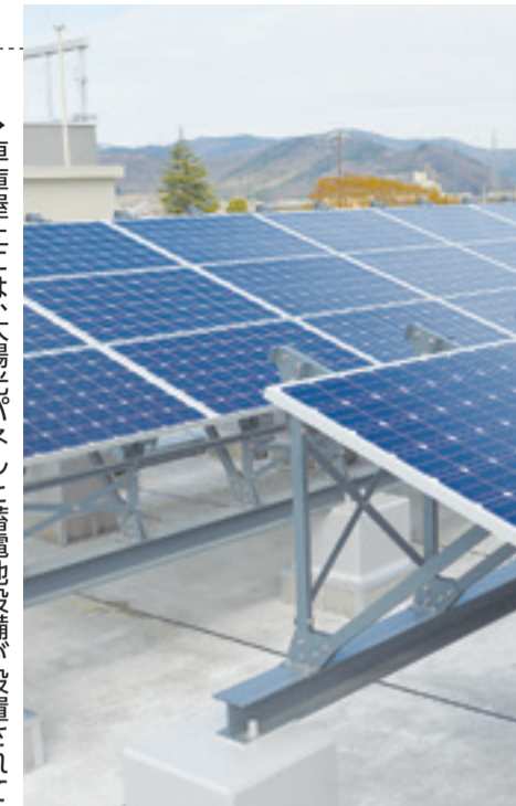
▶車庫屋上には大太陽光パネルと蓄電池設備が設置されています。
