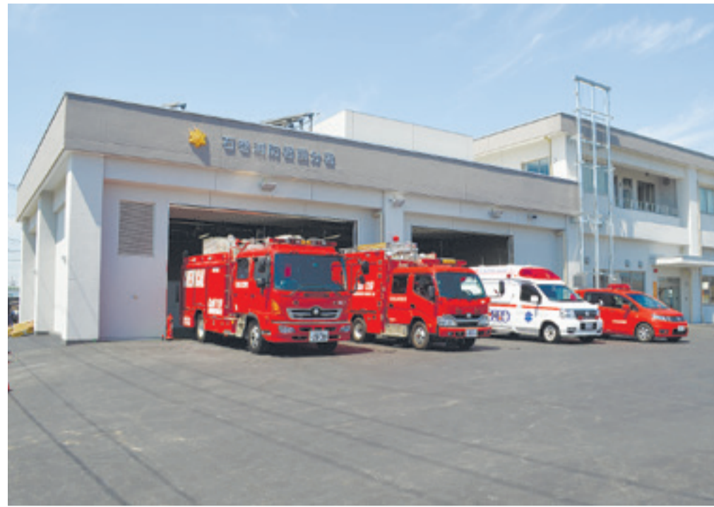
▲建物は、鉄筋コンクリート造2階建です。
