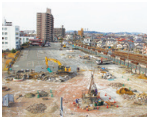
▲昨年10月に建設工事の安全祈願祭が行われ、工事が始まりました。(昨年11月撮影)
