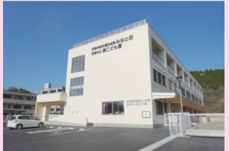
▲4月11日(土)移転新築を進めてきた複合施設の完成を祝い、落成式が行われました。施設は太陽光発電設備や災害用備蓄庫を備える湊地区の拠点避難施設となります
