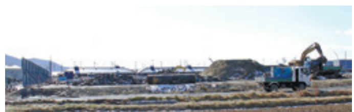
渡波中学校工事風景
