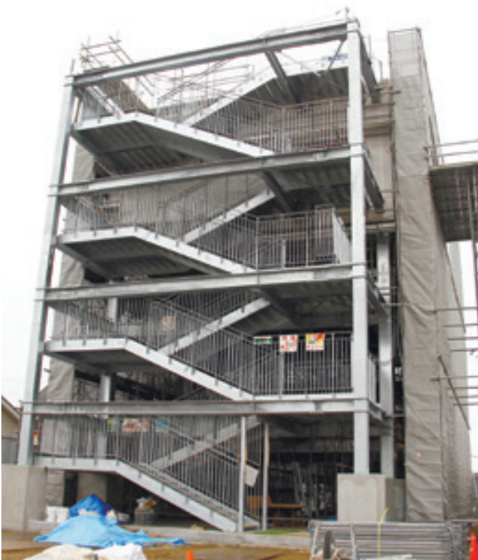
▲高さ13.4メートルの高床式住居です
