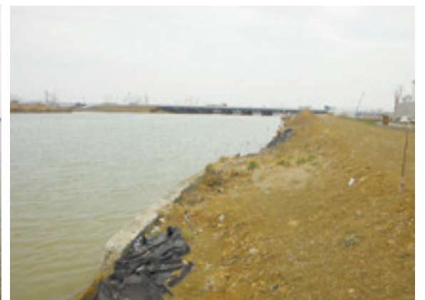
着工前の様子
