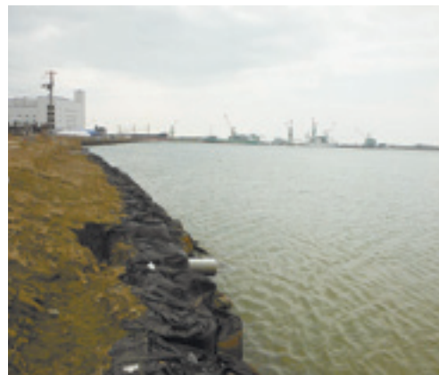
着工前の様子
