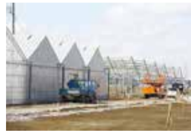
▲施設園芸団地整備工事
