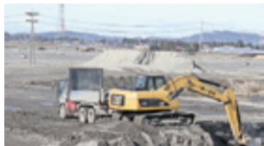
新蛇田地区造成工事
