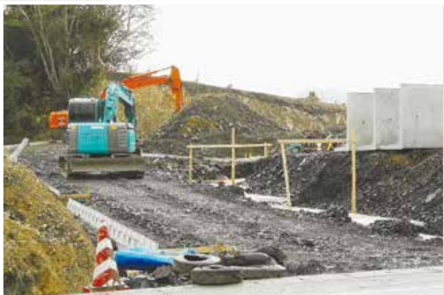
釜谷崎地区(駒の迫団地) 防災集団移転造成工事 ⑨
