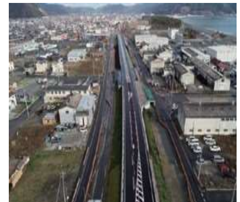
▲高盛土道路 (門脇流留線魚町工区)
