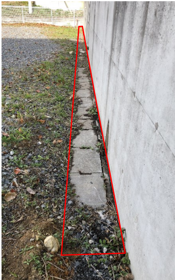
撮影⑧既存宅内側溝
