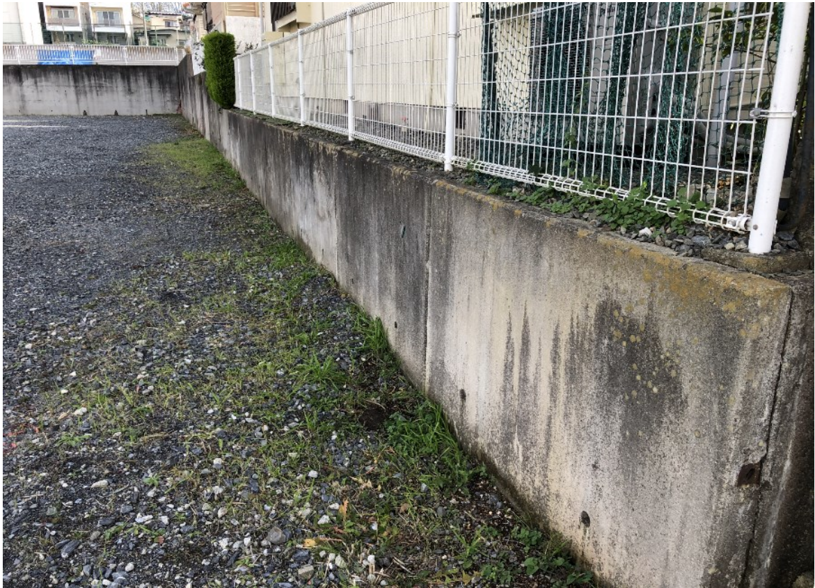
撮影⑫南側隣地擁壁
