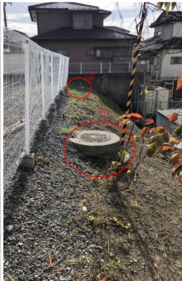
撮影⑨存置マンホール
