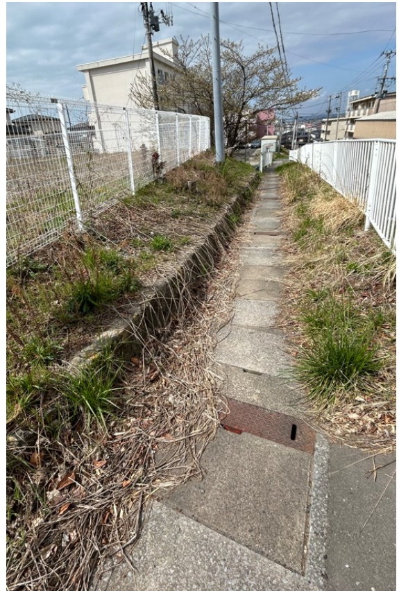
撮影⑤北側市道接面（西側）
