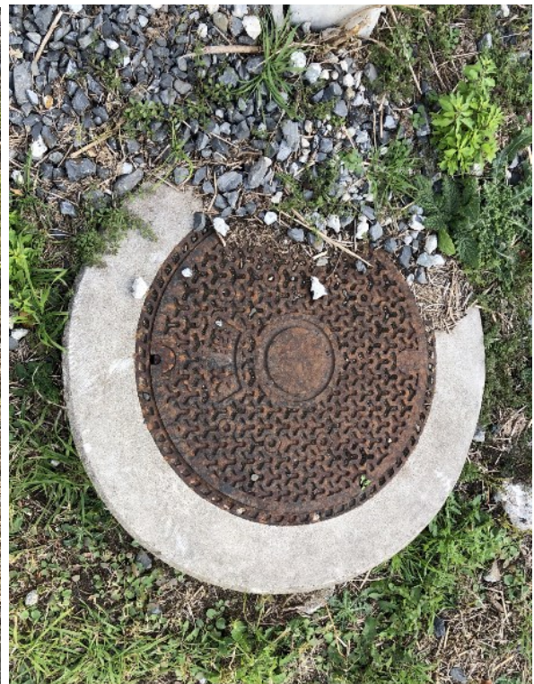
撮影⑪存置マンホール②
