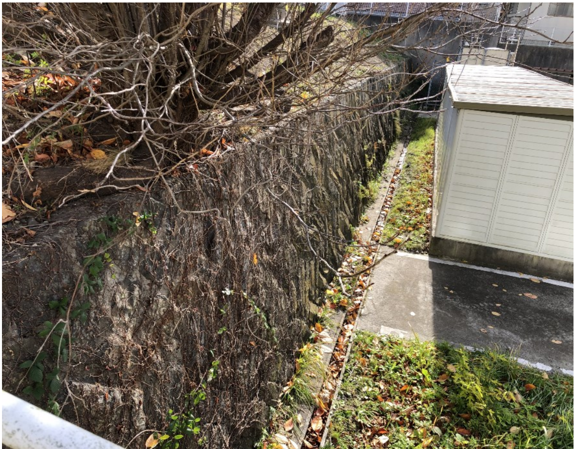
撮影⑬西側隣地擁壁
