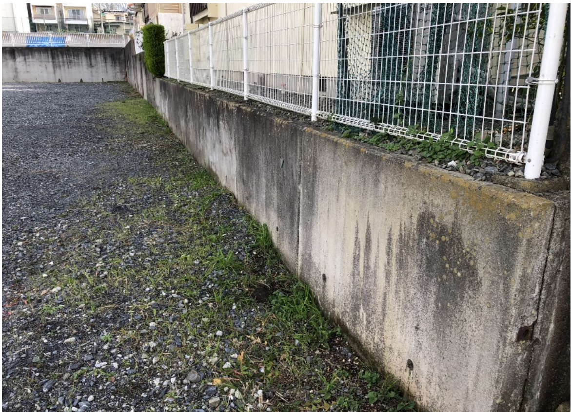
撮影⑫南側隣地擁壁
