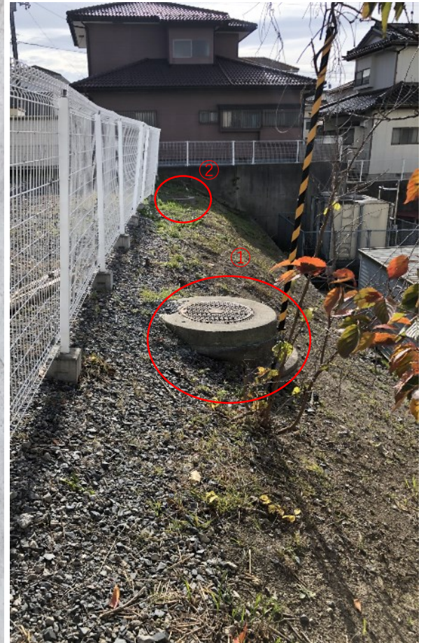
撮影⑨存置マンホール
