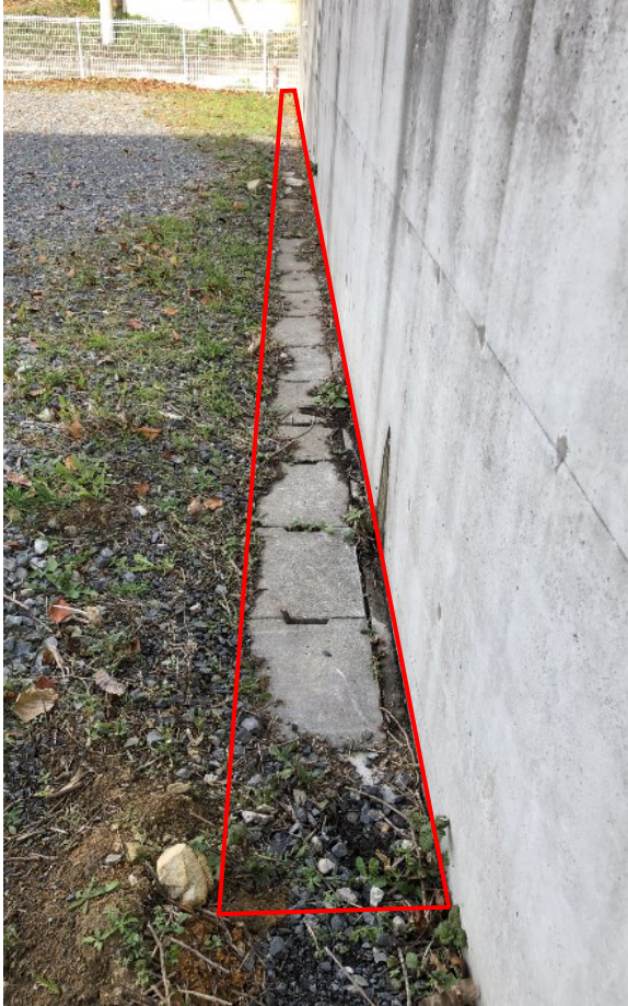
撮影⑧既存宅内側溝
