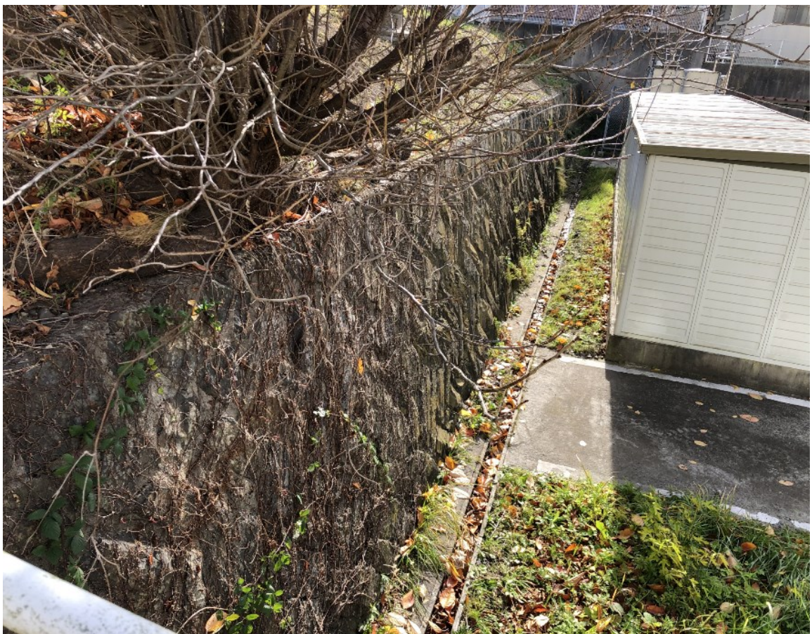
撮影⑬西側隣地擁壁
