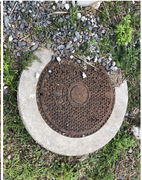
撮影⑪存置マンホール②
