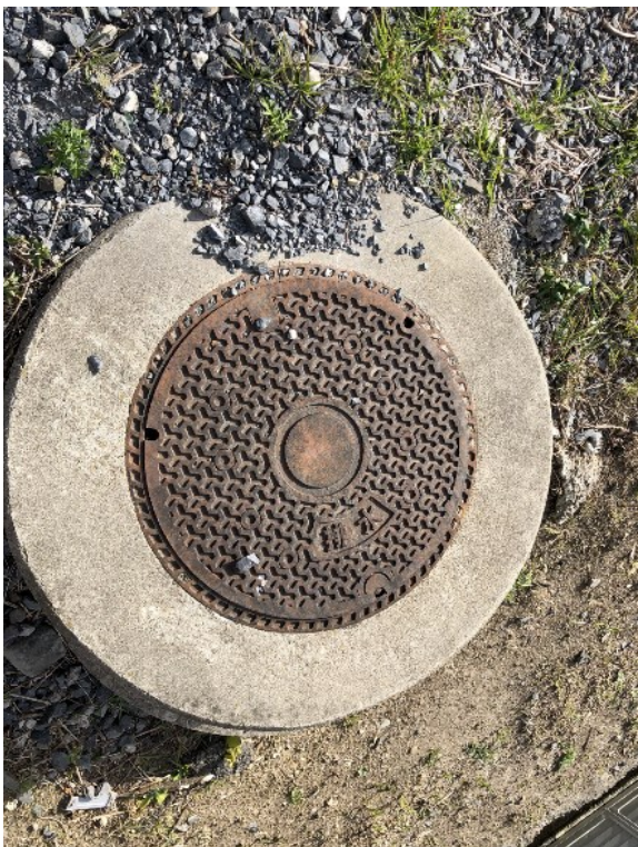
撮影⑩存置マンホール①
