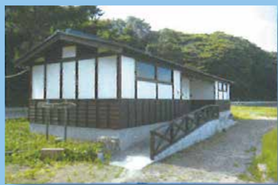
④ 仁斗田公衆トイレ
