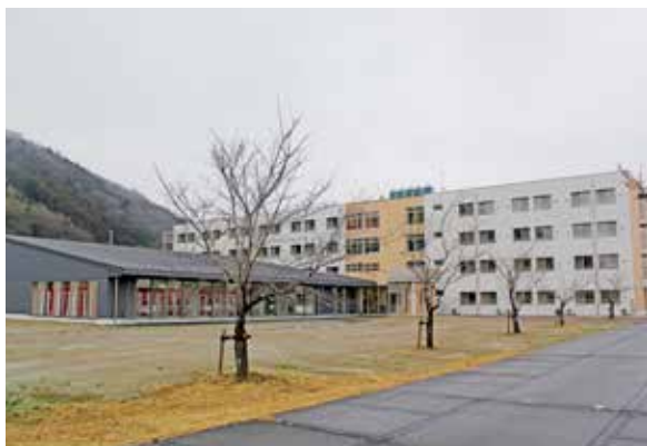
石巻専修大学ユニバーシティハウス
