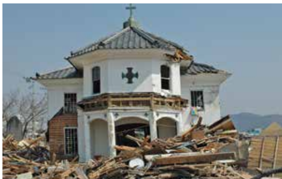
被災した旧石巻ハリストス正教会教会堂
