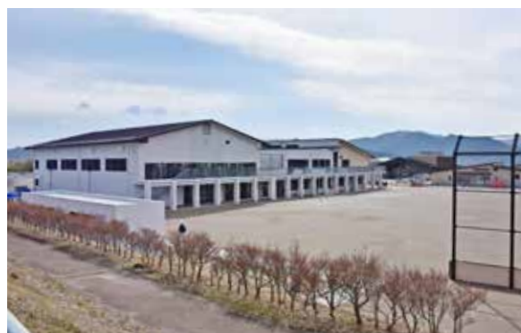
高台に新設した北上小学校校舎
