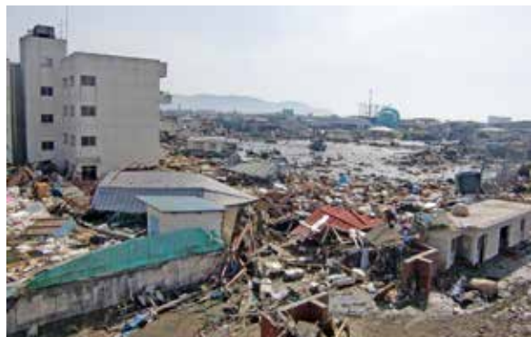
津波で被災した湊中学校
